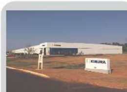
【2014年 7月】 KIMURA, INC. 物流倉庫を竣工
