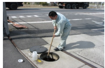
油水分離槽内の排水を分析するための収集作業
